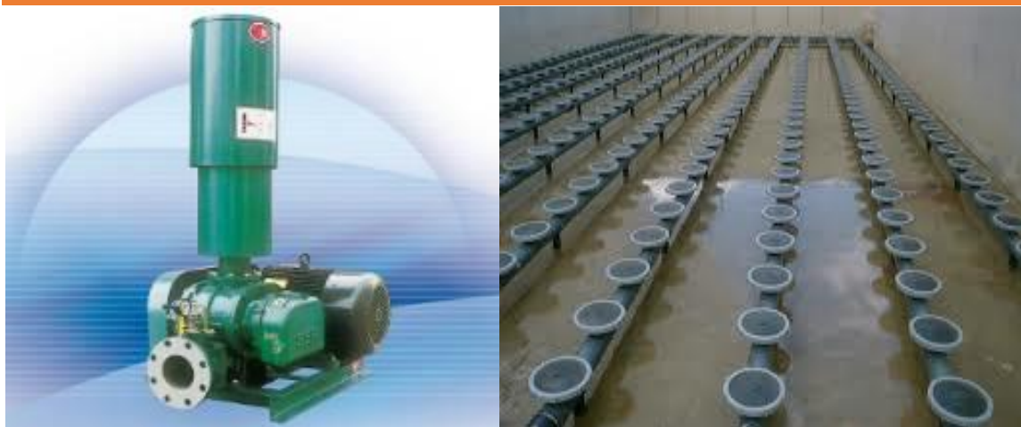
Hình 8. Máy thổi khí và đĩa khí tinh dùng cho bể hiếu khí
