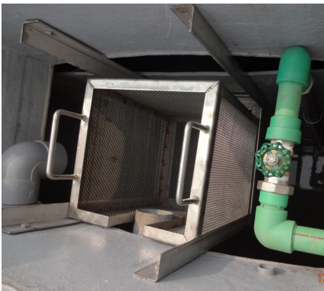
Hình 3.5. Lắp đặt rọ tách rác
